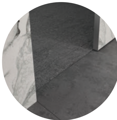
No bottom track/ Brak toru dolnego
