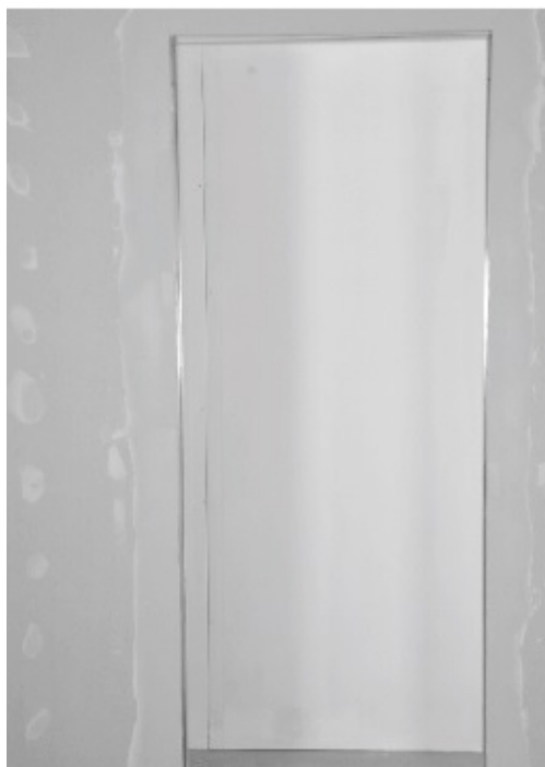
15. Po zagruntowaniu ościeżnicy przystąpić do indywidualnego wykończenia.
