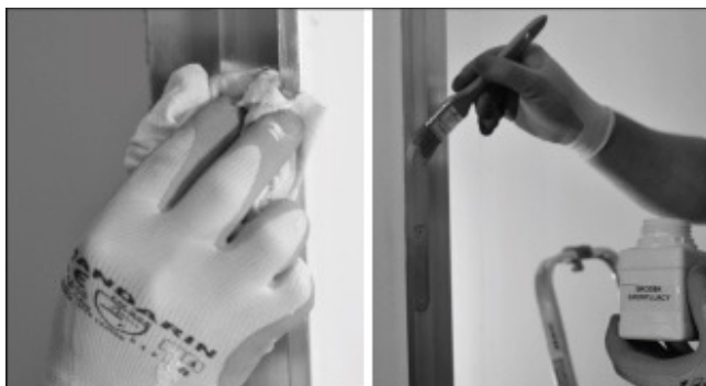
14. Oczyszczyć i odtłuścić ościeżnicę, następnie zagruntować dwukrotnie, drugą warstwę nakładać po wstępnym wyschnięciu pierwszej. Do gruntowania użyć środka gruntującego znajdującego się w akcesoriach dodatkowych.
