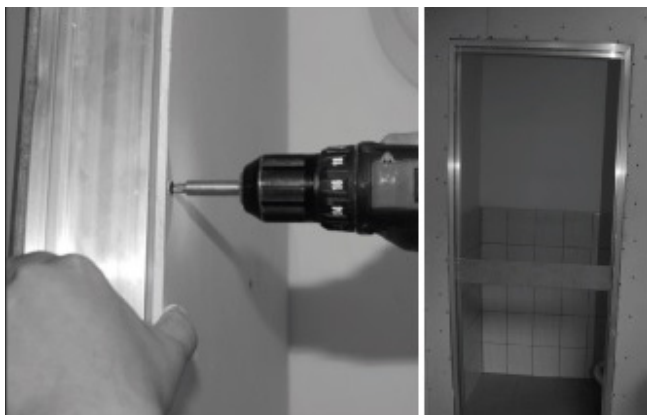
11. Zamontować płyty stelaża.
