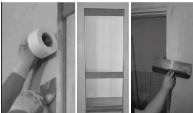
12. Wypełnić szczelinę pomiędzy płytą i ścieżnicą, aby ościeżnica tworzyła jedną płaszczyznę ze ścianą. Należy pamiętać o wykończeniu również drugiej strony ościeżnicy.
